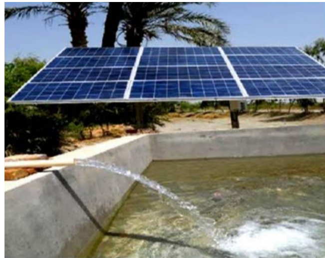
Fig : 15) storage tank
